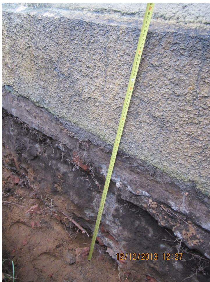
Fot. 2 Odkrywka ław fundamentowych – część podziemna
