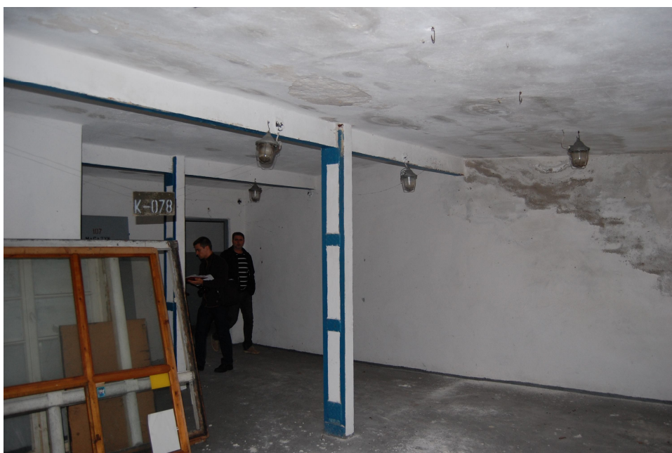
Fot. 9 Stalowa konstrukcja nośna - piętro I
