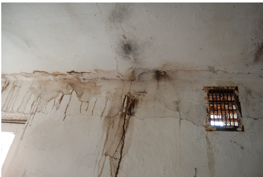
Fot.11 Stropodach – ślady spowodowane korozją stalowych elementów nośnych stropu
