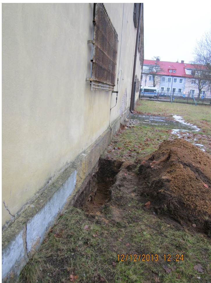
Fot. 1 Odkrywka ław fundamentowych – widok ogólny
