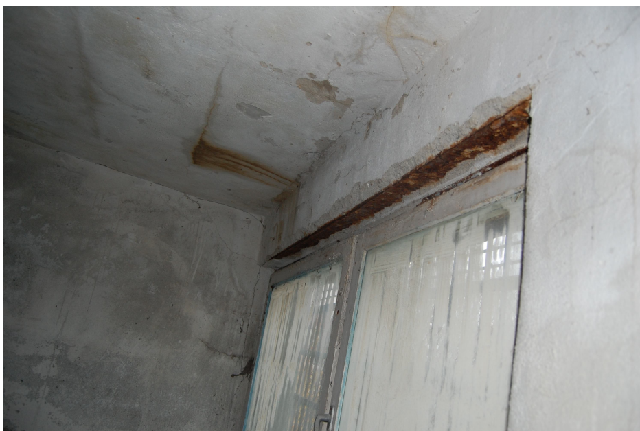
Fot. 13 Nadproże okienne – korozja w efekcie nieszczelności stropodachu
