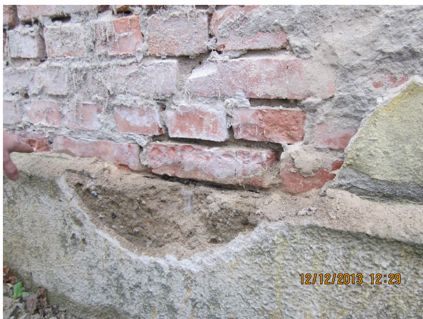
Fot. 3 Odkrywka ław fundamentowych – część nadziemna.
